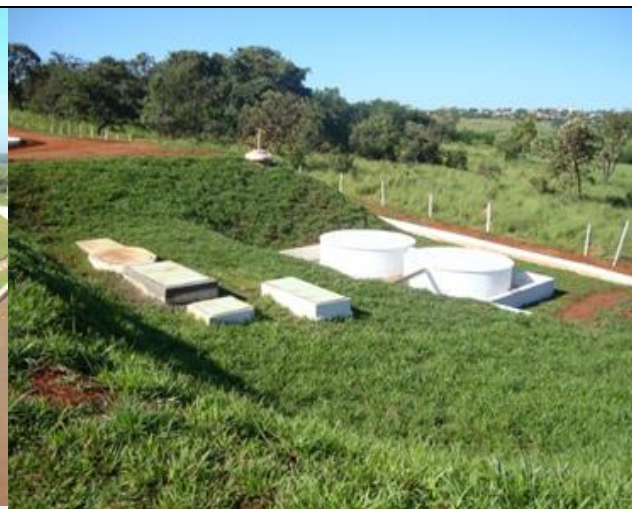
Foto 06 – UCE – Unidade de controle de efluentes
