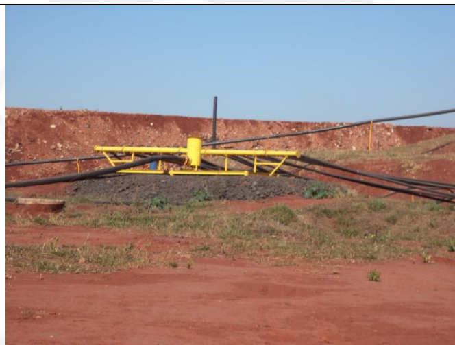
Foto 04 – Sistema de coleta de gás.
