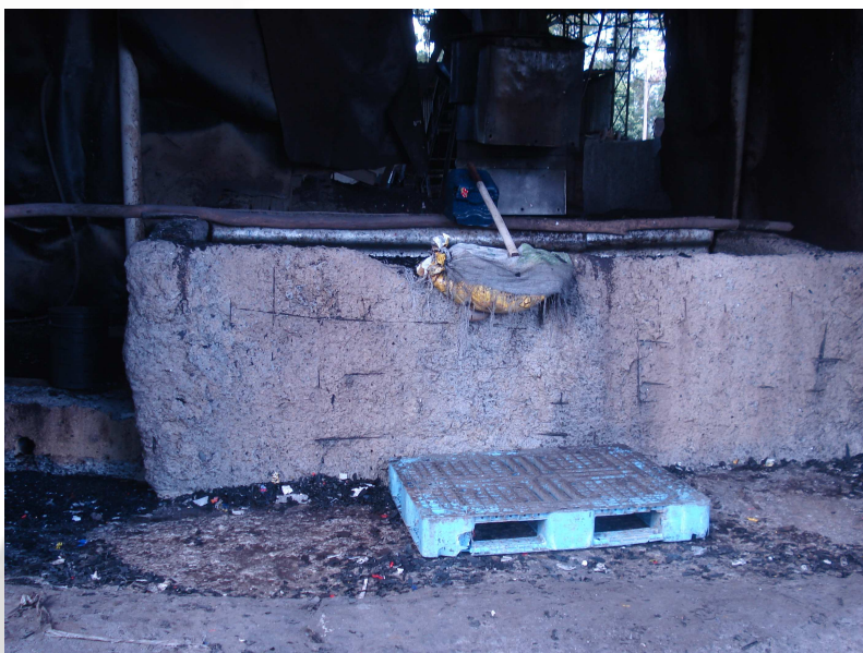
Fig 04: Tanque de solução ácida apresentando corrosão, exposição de ferrugem, trincas e vazamentos para a área externa
