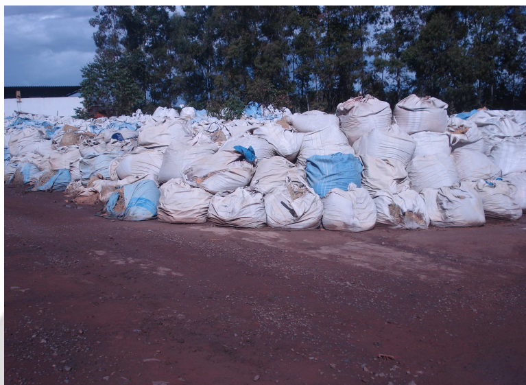
Fig 08: Grande quantidade de lodo da ETE armazenada a céu aberto e diretamente sobre o solo
