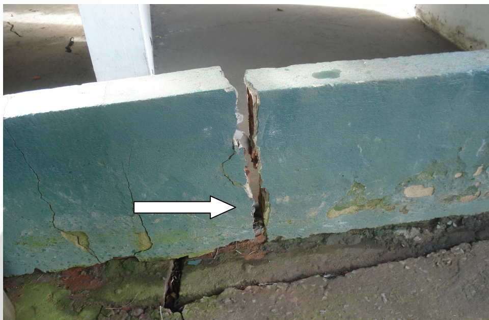
Fig 15: Rachadura em bacia de contenção
