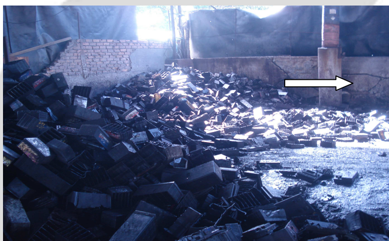
Fig 01: Vista do local onde baterias são serradas, local sem a devida impermeabilização, ausência de canaletas de contenção, rachaduras nas paredes
