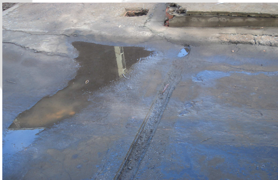
Fig 16: Área em desacordo com DN 108/2007, ausência de caixa separadora de água e óleo canaletas sem função
