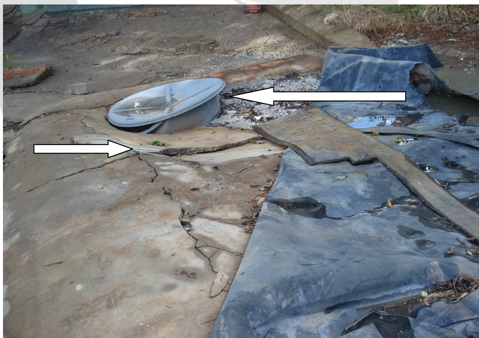
Fig 18: Local para armazenagem de carcaças de bateria, sistema de coleta de efluentes com trincas e rachaduras, sem função de contenção.
