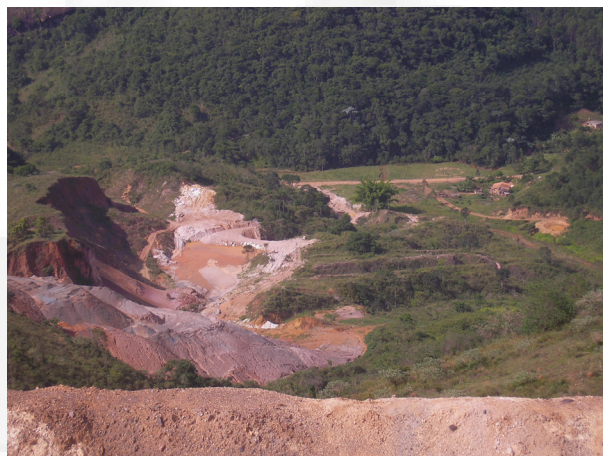
Foto 04. Local da futura pilha de estéril
