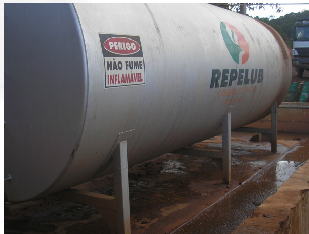
Foto 02. Ponto de abastecimento de combustível
