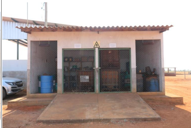
Foto 04. Depósito temporário de resíduos oleosos.
