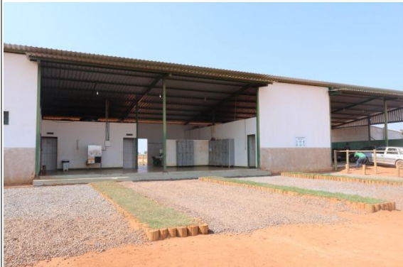
Foto 05. Vista frontal do galpão de apoio.
