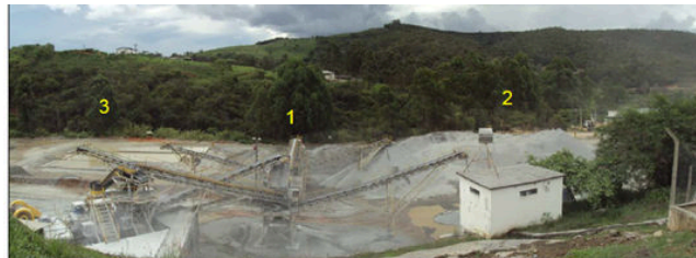
Vista geral da área de beneficiamento. Em primeiro plano observa-se a I.T.M. de britagem e peneiramento (1) ao fundo o pátio de produto (2) e a área de decantação do efluente gerado na produção de areia de gnaíse (3).
