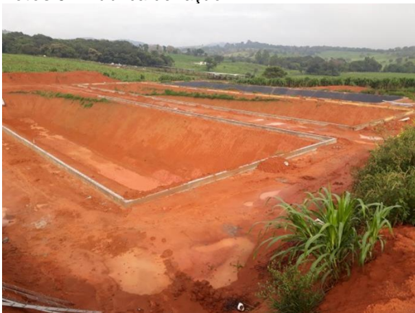
Fotos 10 – Sistema de tratamento de efluentes em construção.
