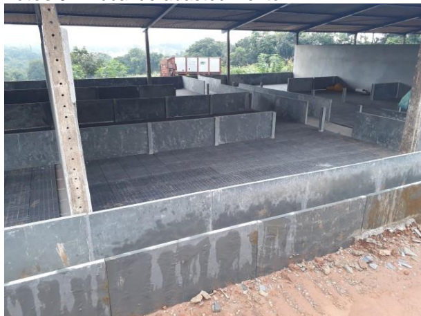
Foto 11 – Galpões em construção.
