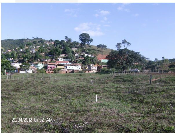
Foto 03. Local a ser implantado o canal para desvio do rio São Manoel após a confluência.
