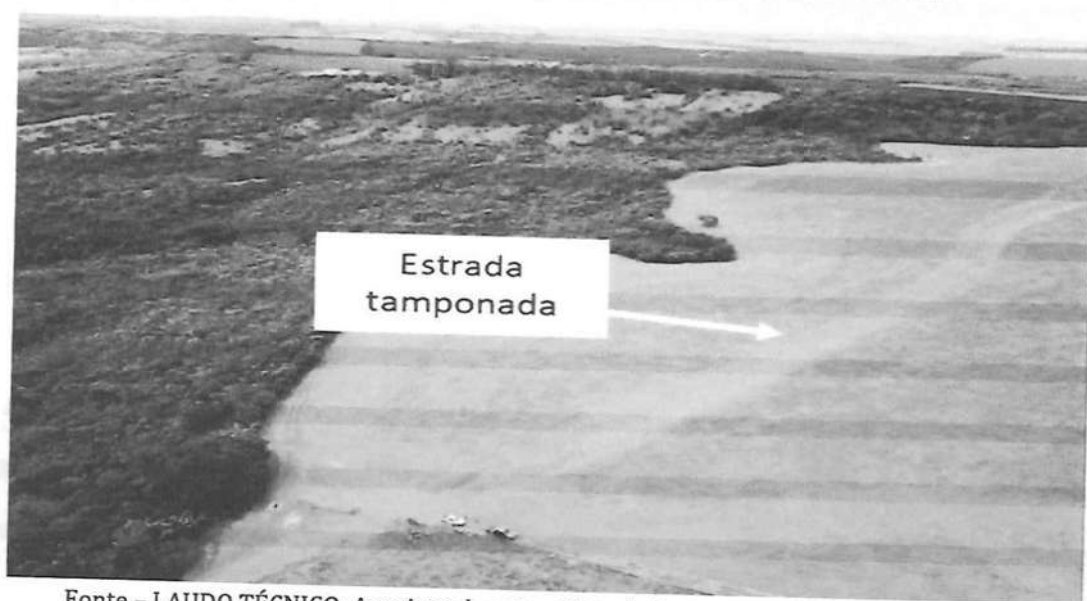
Figura 10 – Vista aérea da área onde ocorreu o corte de árvores isoladas
