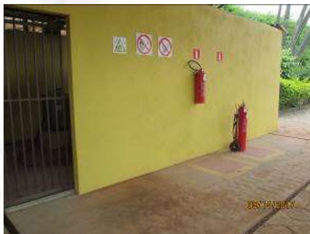
Fig. 08 - Local do posto de abastecimento do empreendimento.
