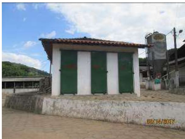
Fig. 11 - DTR utilizado dentro do empreendimento
