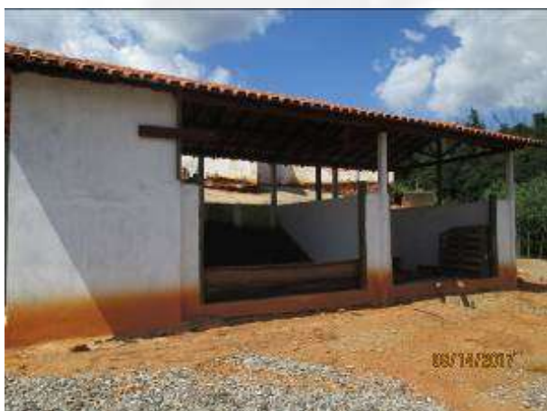
Fig. 13 - Células de compostagem utilizadas no empreendimento.
