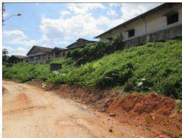
Fig. 02 - Revegetação nos taludes e encostas do empreendimento
