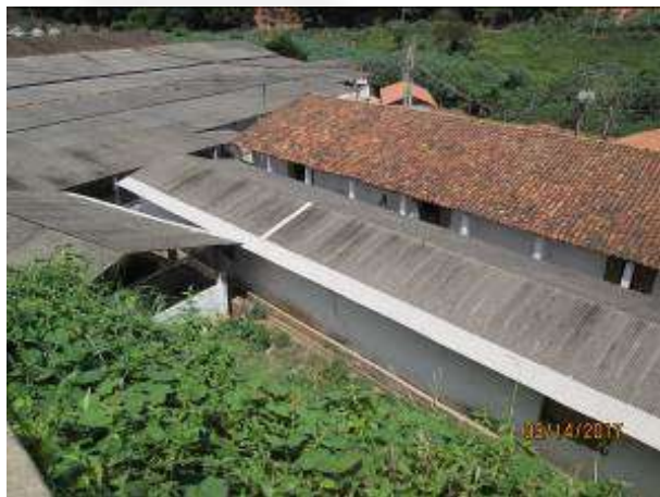
Fig. 03 - Canaleta de recolhimento de dejetos dentro da projeção da calha do telhado
