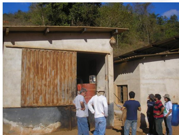
Foto 04. Depósito de óleos lubrificantes.
