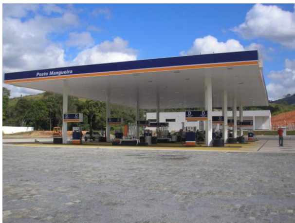
Foto 01. Vista geral da pista de abastecimento e anexos ao fundo.
