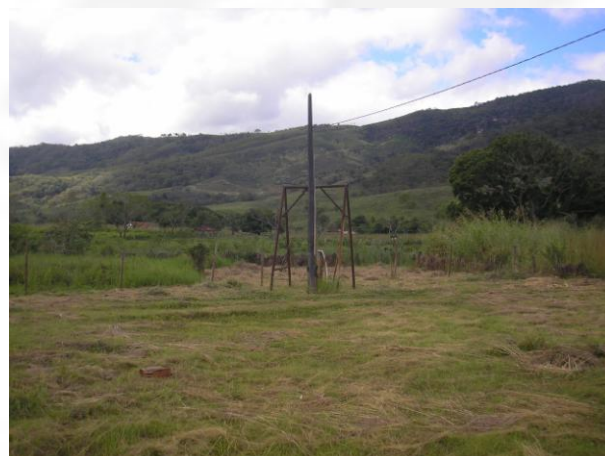
Foto 04. Ponto de captação de água do empreendimento.
