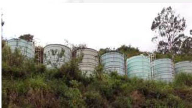
Foto 09. Reservatório de água
