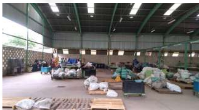
Foto 04. Setor de pequenos reparos e passagem
