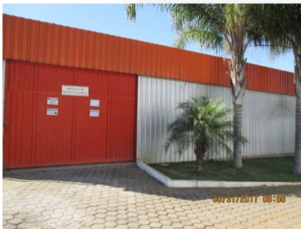
Foto 01. Área de armazenamento de produtos químicos
