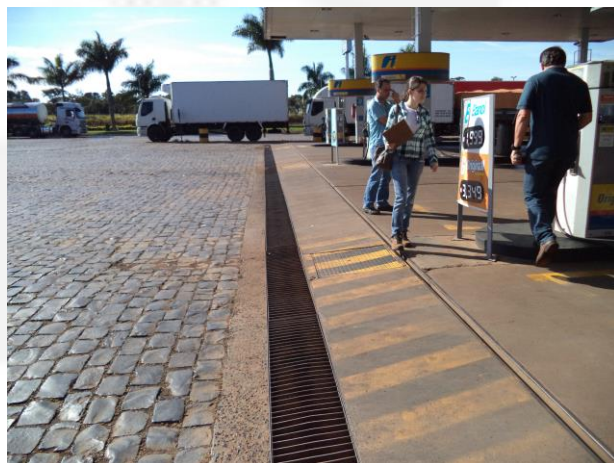
Foto 04: Canaleta para captação de águas oleosas e grelha para captação de águas pluviais
