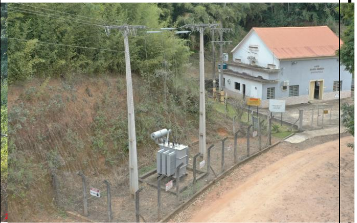
Foto 5: Casa de Força. Fonte: Relatório Técnico de Situação.
