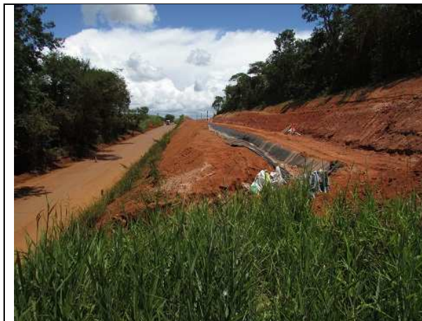
Foto 6: Obra de drenagem na parte mais alta do trecho.
