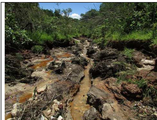
Foto 17: Alteração do leito e margens do curso d'água.
