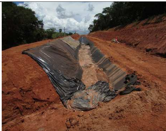
Foto 7: Obra de drenagem na parte mais alta do trecho.
