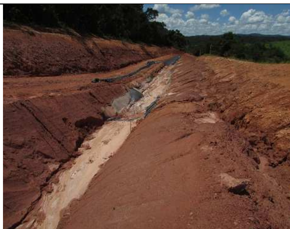
Foto 9: Obra de drenagem na parte mais alta do trecho. Notar movimentação de sedimentos.
