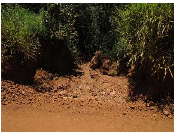
Foto 3: Saída de água sem dispositivo de controle de drenagem.
