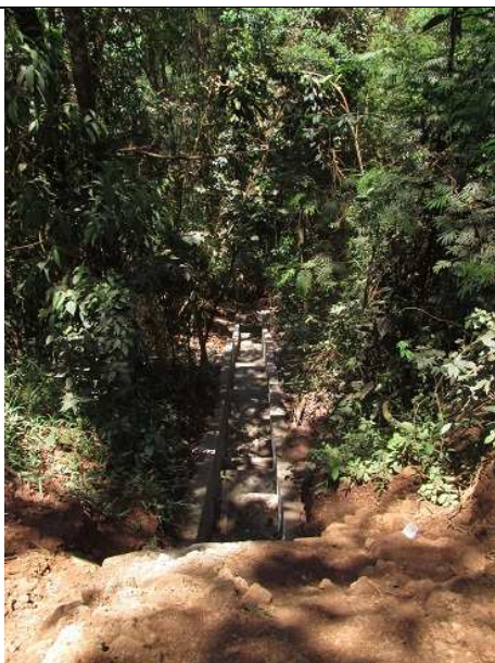
Foto 10: Escada para dissipação de energia da água.
