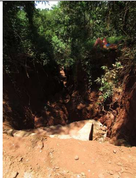
Foto 2: Obras em andamento.
