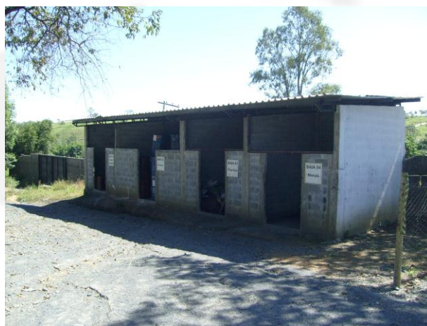
Foto 08. Depósito temporário de Resíduos Sólidos
