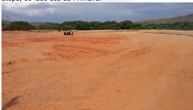
Foto 3: Local de instalação dos futuros Filtros Biológicos e Decantadores
