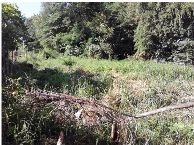
Foto 13: Local da Estação Elevatória EE SD-03
