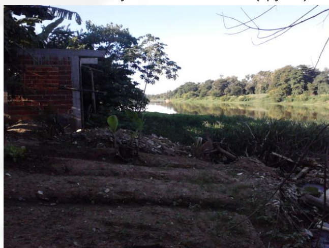
Foto 10: Local da Estação Elevatória EE SD-01
