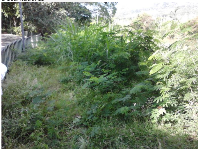
Foto 5: Local da Estação Elevatória EE IA-01
