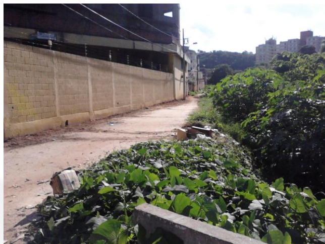
Foto 14: Local da Estação Elevatória EE SD-04
