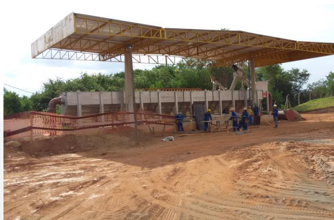
Foto 2: Área onde será instalado o Pré-Tratamento 02, ao lado do Pré-Tratamento 01, em fase final de montagem.
