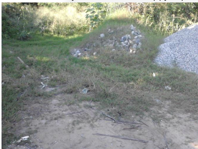
Foto 9: Local da Estação Elevatória EE SR-02
