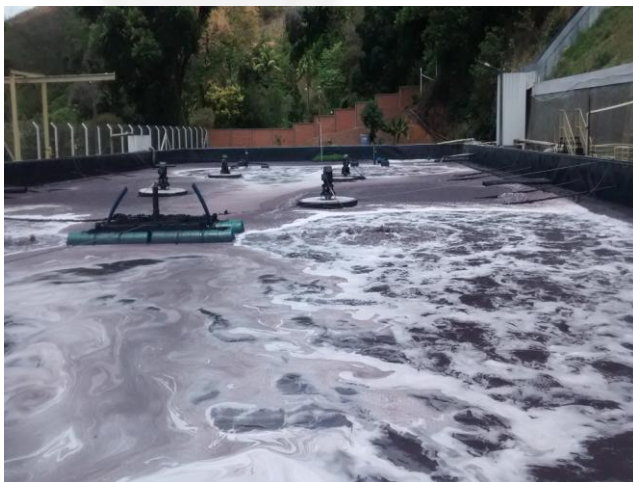
Fig. 07 – Tanque de Aeração
