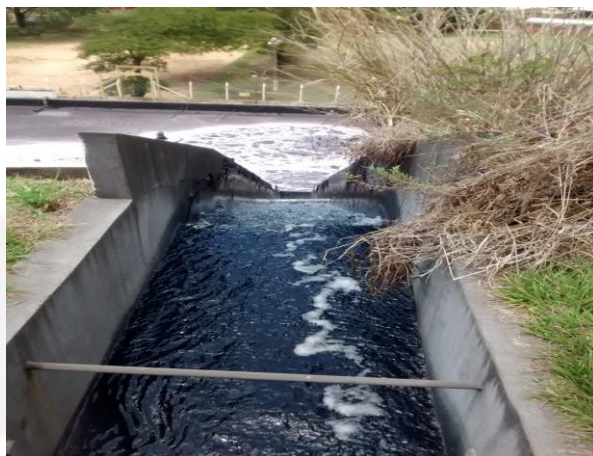
Fig. 06 – Caneleta responsável pelo envio dos efluentes para o tanque de aerção.
