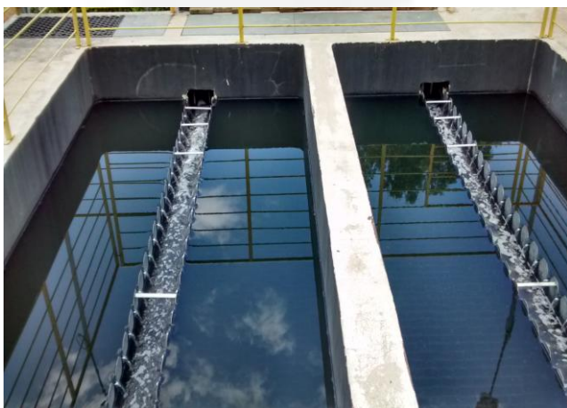
Fig. 11 – Término do processo de floculação e decantação.
