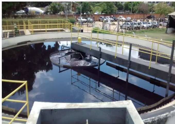
Fig. 08 – Decantador Secundário
