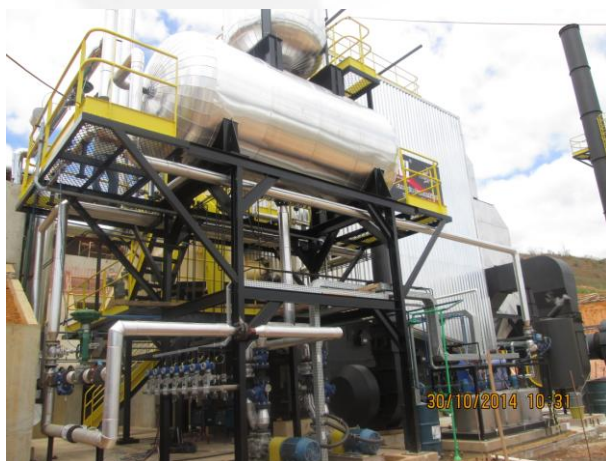
Fig. 23 – Nova caldeira movida a cavaco em fase final de instalação.
