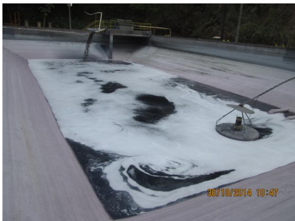
Fig. 05 – Caixa de equalização, que funciona também como tanque pulmão.
