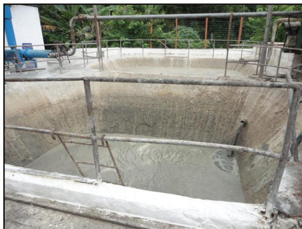
Foto 04: Tanque de decantação do efluente da depilação.
