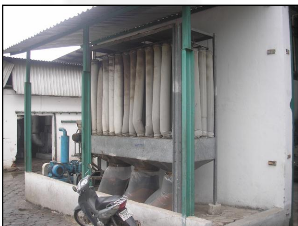
Foto 05: Filtro de manga do setor de lixamento.
