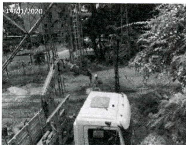
Figura 6: Retirada da bombona do local do incidente.
