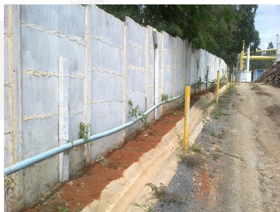
Foto 04. Cortina arbórea implantada e sistema de drenagem pluvial
