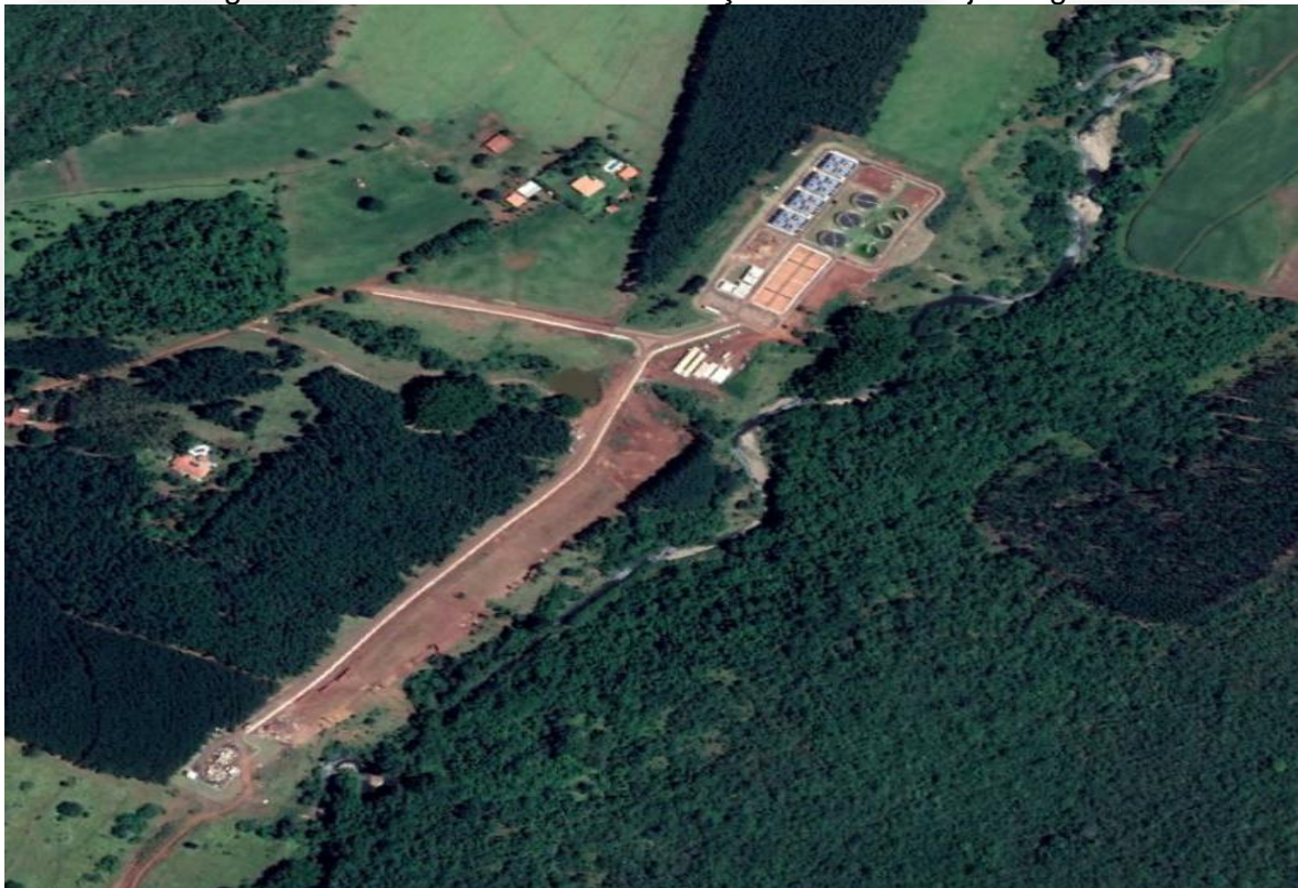
Figura 01 – Área destinada a instalação da ETE –Brejo Alegre.
