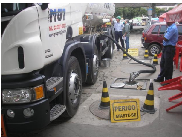
Foto 07. Bocas de descarga concretadas em seu entorno, e circundadas com canaletas.
