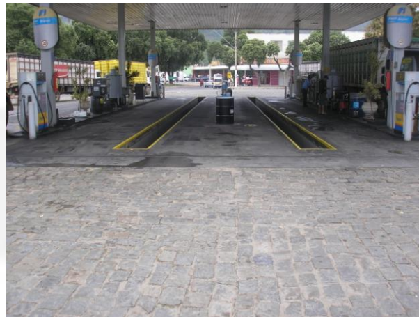
Foto 02. Pista de abastecimento de diesel.
