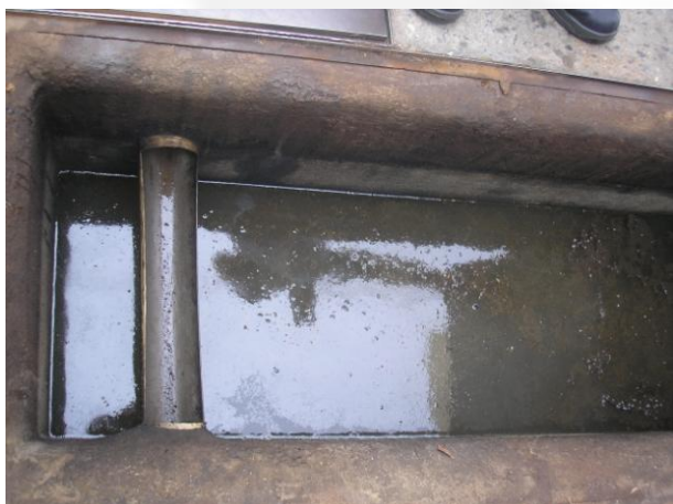
Foto 05. Vista superior da CSAO da pista de abastecimento de gasolina e etanol e troca de óleo.
