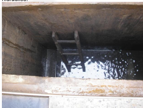
Foto 06. Vista superior da CSAO da pista de abastecimento de diesel e rampas de troca de óleo de caminhões.
