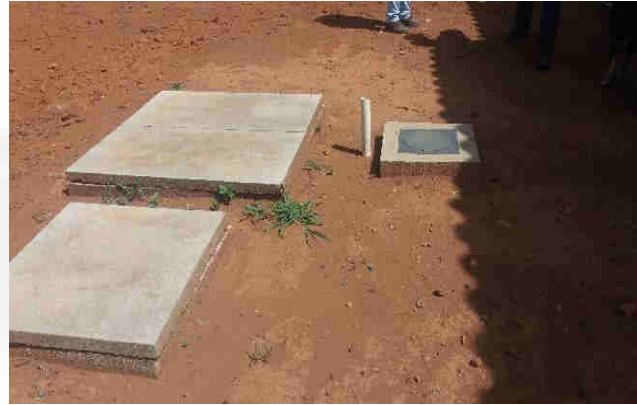
Foto 02. Fossas sépticas instaladas
