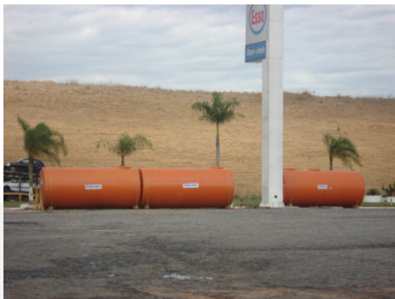
Foto 03: Tanques novos que estão sendo instalados na reforma do Posto
