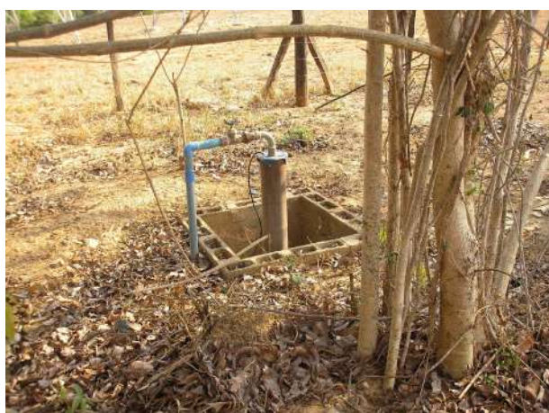
Foto 03. Poço tubular para consumo humano
