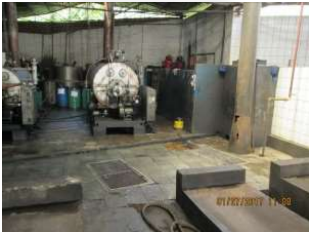
Foto 13 – Caldeira utilizada para desgaseificação dos tanques de transporte de produtos químicos.
