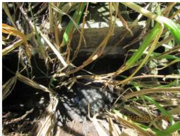
Fig. 18 – O que era para ser a caixa SÃO do empreendimento totalmente tomada por mato e assoreada.
