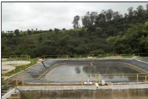
Foto 03. Lagoa da ETE.
