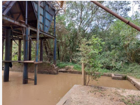
Foto 02. Sistema de decantação do Porto Niterói.
