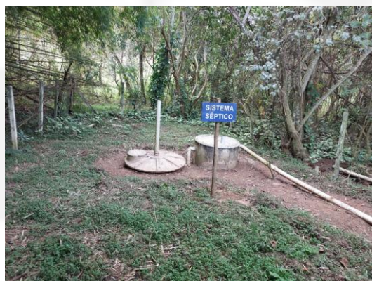
Foto 06. Sistema de tratamento de efluentes sanitários
