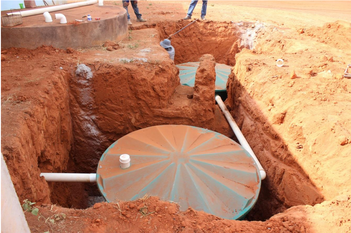
Foto 1 - Instalação de unidade de tratamento de Efluente Sanitário
