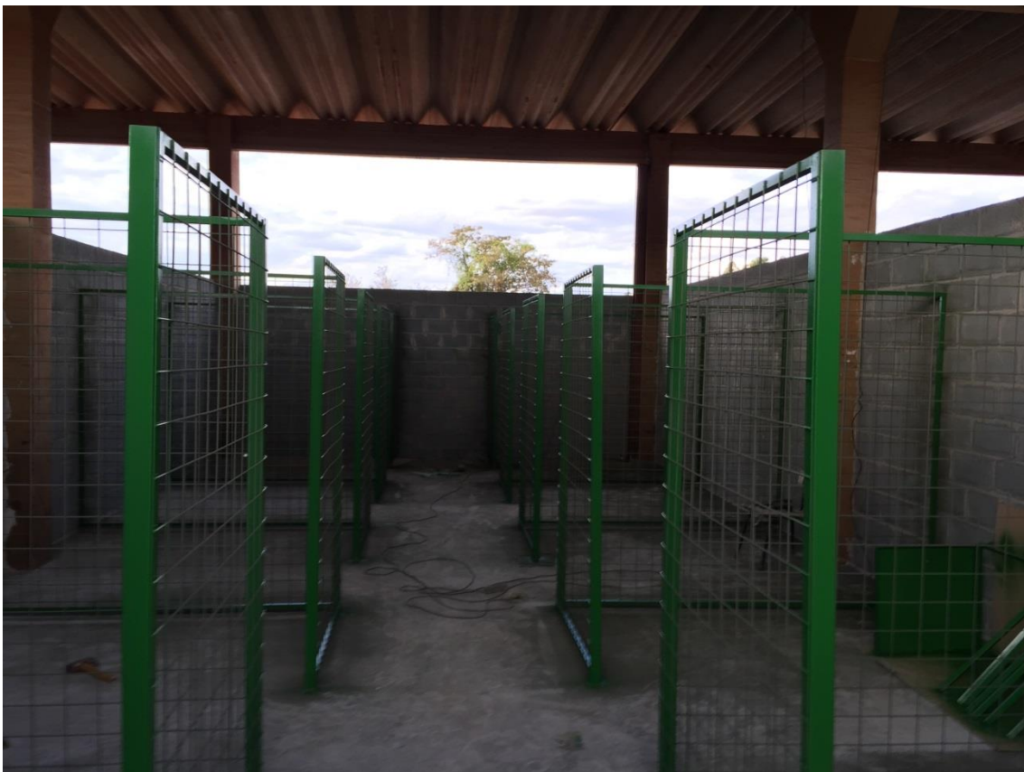
Foto 4 - Interior do depósito de resíduos
