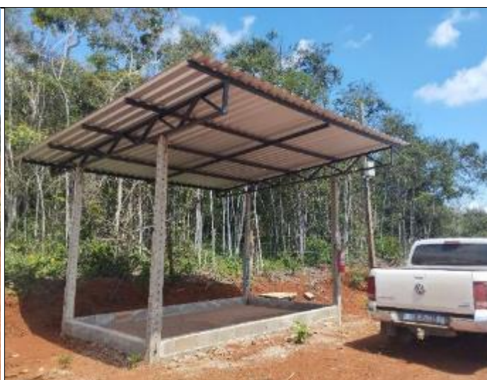
Foto 8: Estrutura de abrigo do gerador a diesel, que alimentará os equipamentos para a lavra
