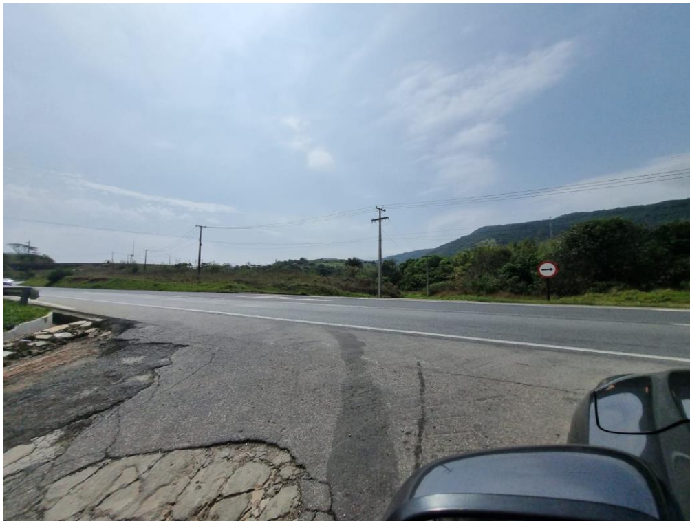
Figura 15 - Acesso pela Rodovia sem pista de desaceleração e com curva de 90°.
