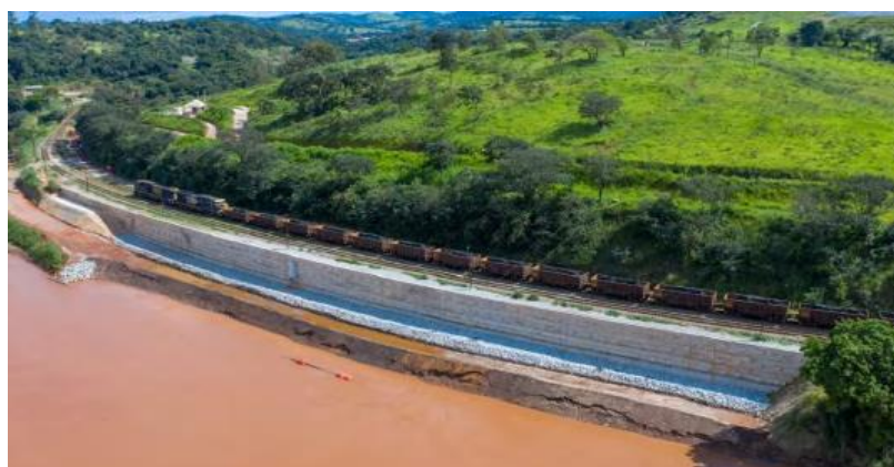
Figura 17 - Estabilização do talude da Ferrovia MRS. Fonte: PCIA Projetos Diversos, Vale 2024.
