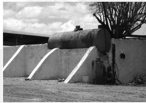
Foto 04. Ponto de abastecimento
