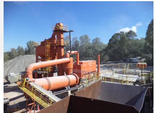
Foto 06. Vista geral da usina.
