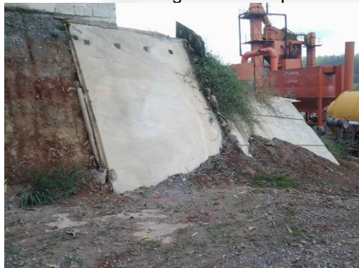
Foto 05. Placas de concreto no talude.
