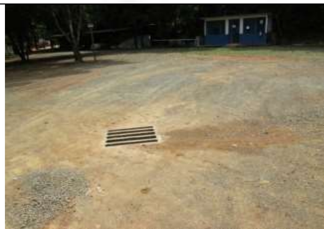
Foto 2: Pátio com drenagem de água pluvial
