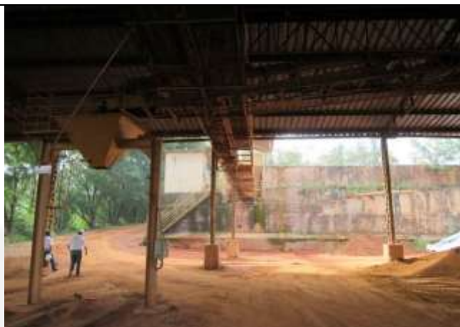
Foto 18: Pátio de bauxita que alimenta os moinhos
