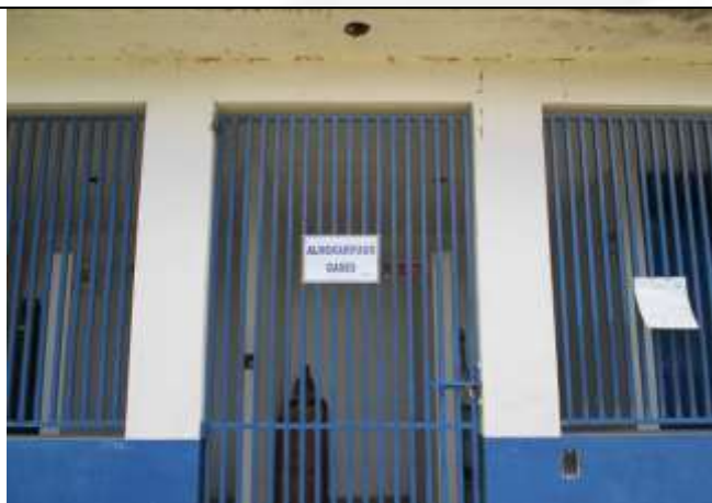
Foto 7: Depósito de oxigênio e acetileno
