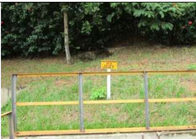
Foto 20: Caixa SAO do lavador de veículos e do Tanque de Abastecimento
