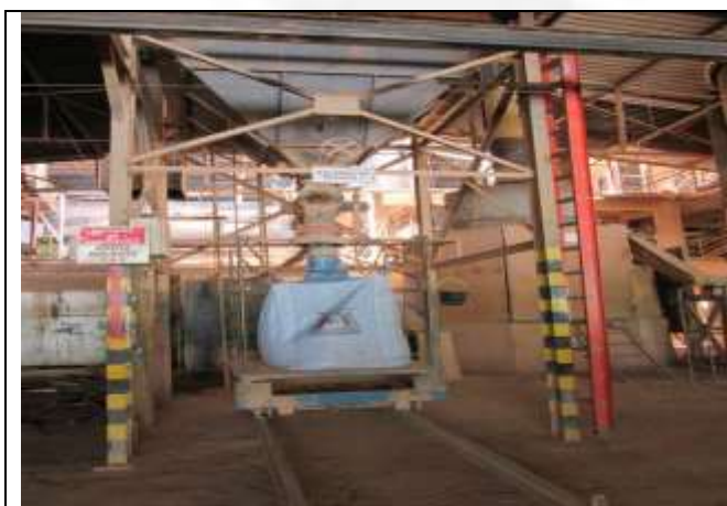
Foto 15: Big bag sendo enchido com moinho com revestimento acústico ao lado
