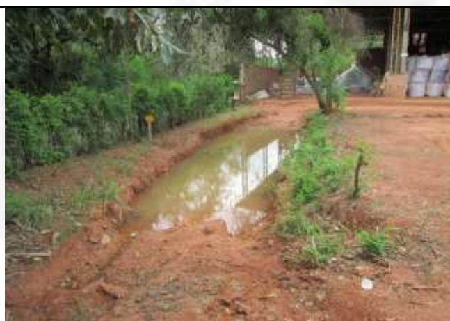
Foto 10: Bacia de contenção de água pluvial
