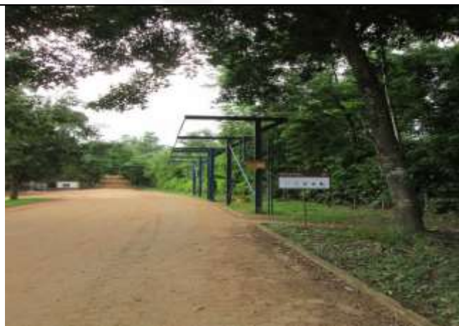
Foto 8: Estrutura usada para cobrir os caminhões
