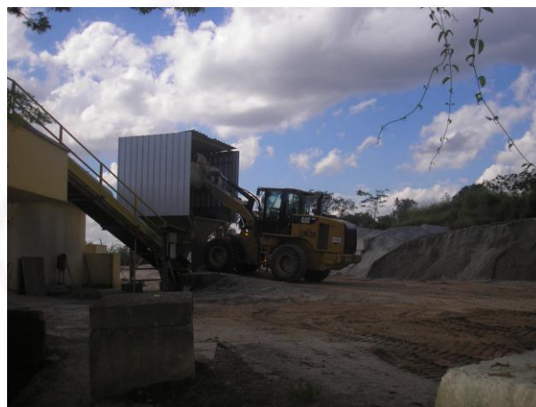
Foto 04. Pátio de armazenamento dos insumos e carregamento.
