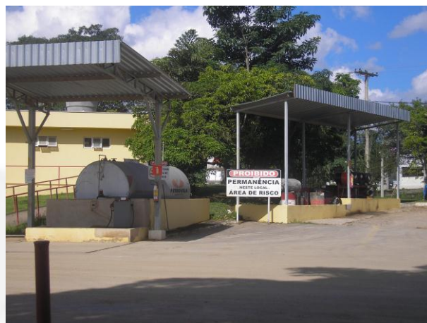
Foto 02. Posto de abastecimento e local de armazenamento do óleo.
