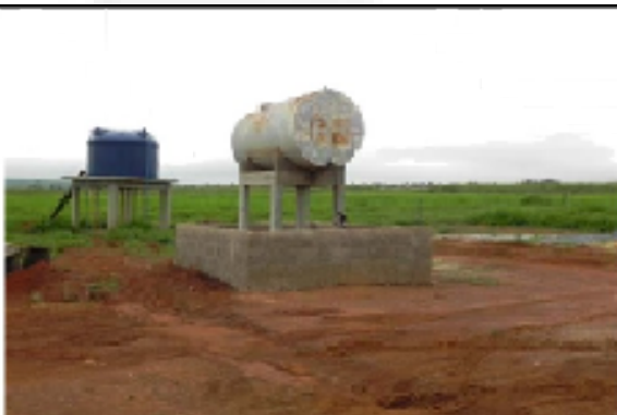
Foto 3: Ponto de abastecimento
