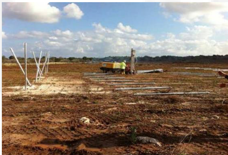
Figura 4. Imagem de como será feita a fixação dos parafusos no solo. Fonte: RCA do empreendimento.
