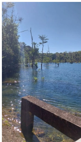
Foto 9. Barramento. Fonte: Registro em vistoria.
