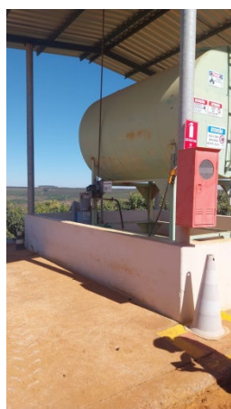
Foto 7. Posto de abastecimento. Fonte: Registro em vistoria.
