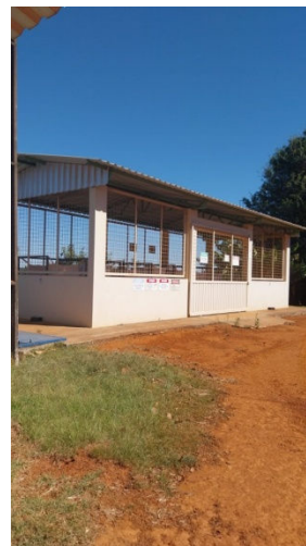
Foto 6. Depósito de embalagens vazias de agrotóxico. Fonte: Registro em vistoria.
