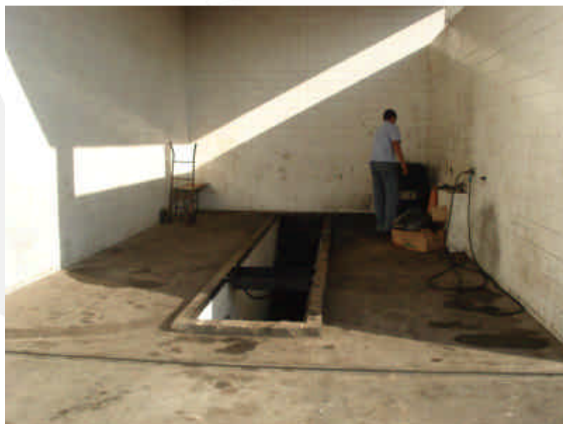
Foto 02. Área de troca de óleo.
