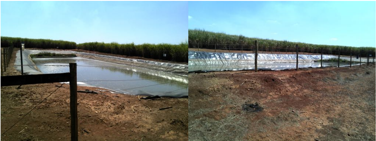
FIGURA 7: VISÃO GERAL DO RESERVATÓRIO DA CASA DE BOMBA V FAZENDA SOUZA.
