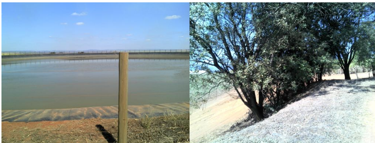
FIGURA 4: A ESQUERDA, VISTA GERAL DO RESERVATÓRIO I CAPOEIRA DA CANA; A DIREITA, VEGETAÇÃO ARBÓREA EM SEUS TALUDES.
