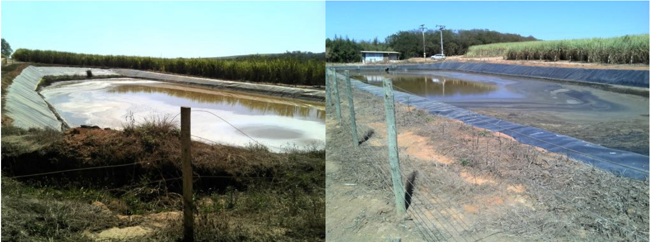
FIGURA 7: VISÃO GERAL DO RESERVATÓRIO DA CASA DE BOMBA IV FAZENDA MUNDEL.
