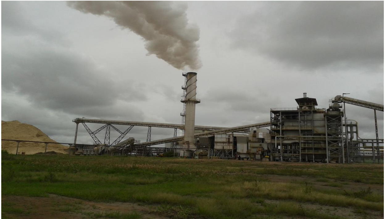
Figura 13- Caldeira utilizada na queima do bagaço de cana-de-açúcar.
