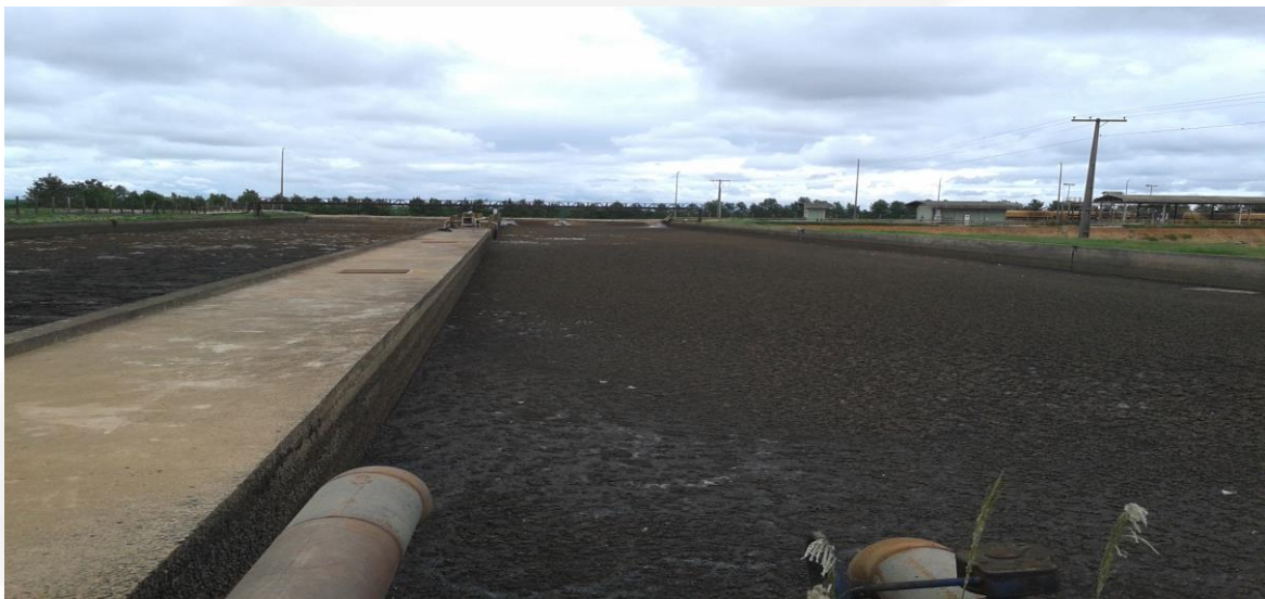
Figura 08 – Tanques de água residuária
