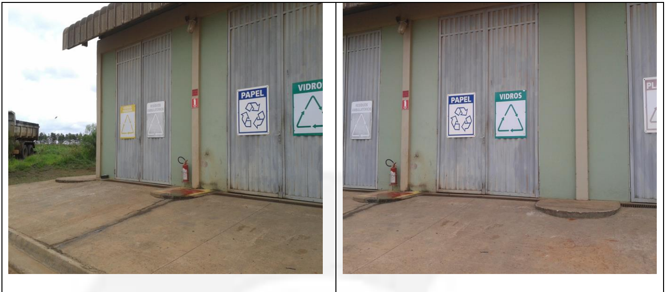
Figura 11 – Local de armazenamento temporário de resíduos.
