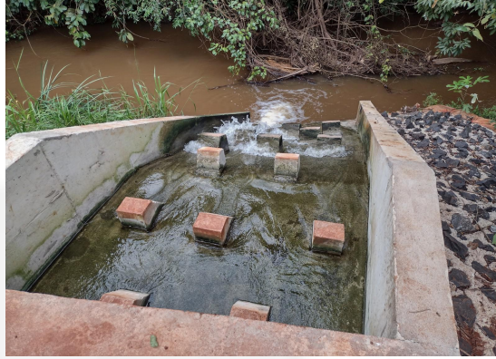
Novo emissário de efluentes tratados
