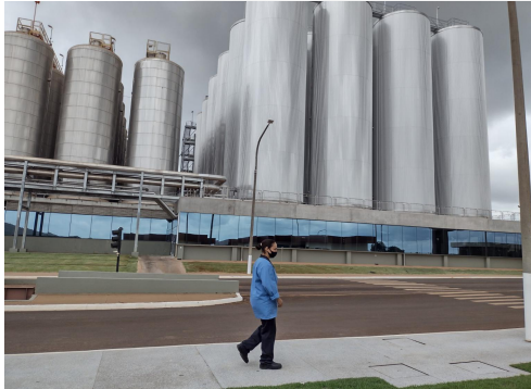
Vista externa da área industrial
