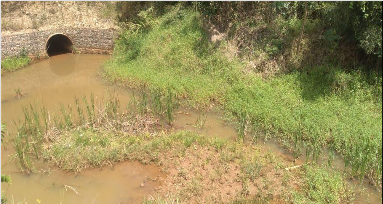
Foto 5: Córrego Feijão Cru, ponto de saída pelo bueiro existente por sob a rodovia MG-329 correspondente ao local de lançamento dos efluentes tratados na ETE da CTR BITURUNA.
