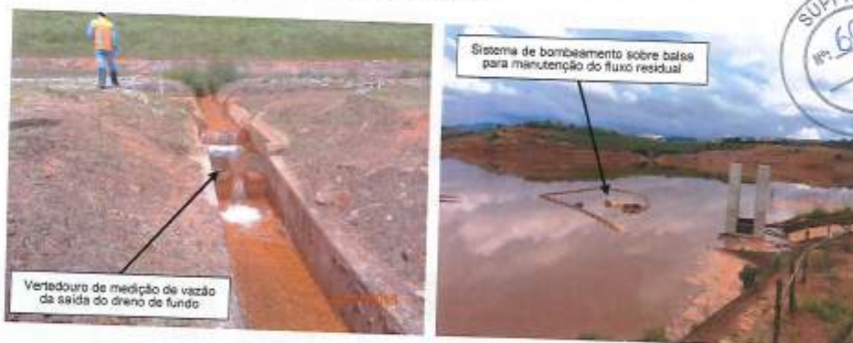
Figura 3.11 - Dispositivos de manutenção do fluxo residual a jusante da Barragem de Rejeitos.
