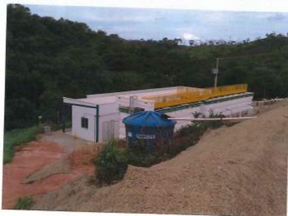
Figura 3.12 – Estação de tratamento de efluente (ETE) instalada a jusante da Barragem de Rejeitos para o tratamento das vazões residuais.
