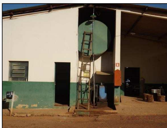
Foto 02. Ponto de abastecimento
