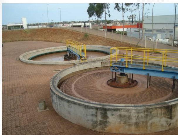
Foto 09: Vista do decantador secundário e adensador.
