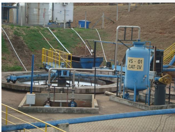
Foto 07: Vista do tratamento preliminar (peneira) e flotor
