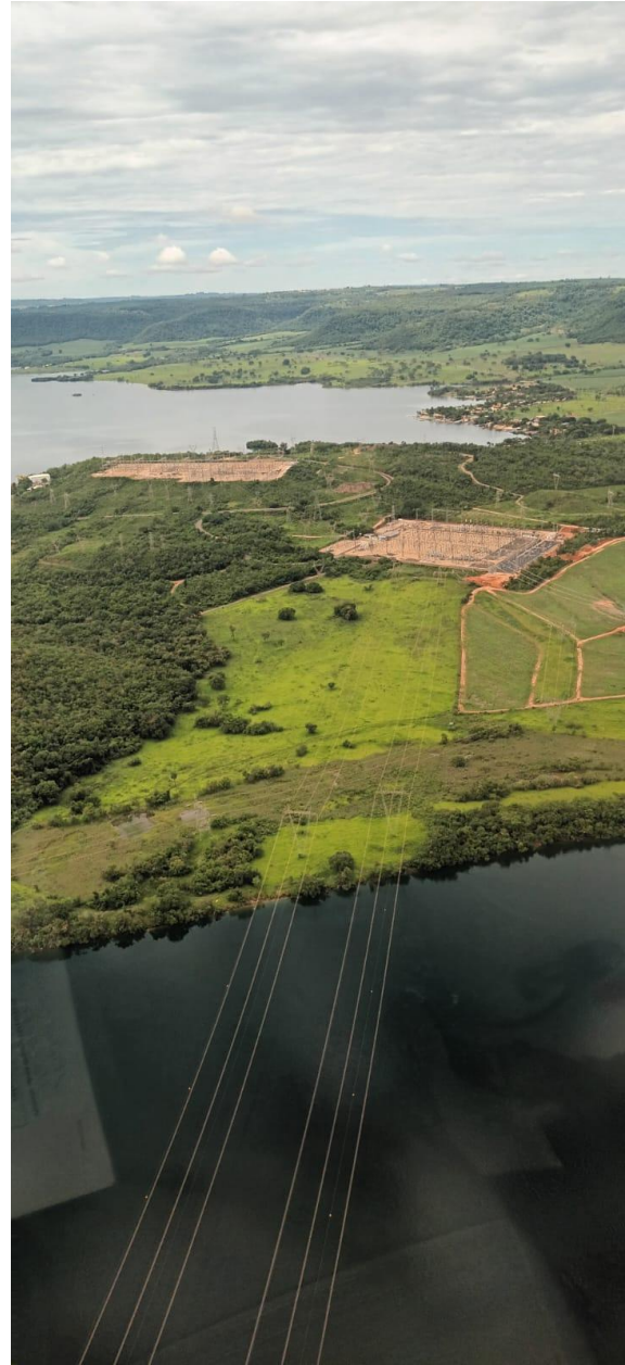
Figura 4: Área Diretamente Afetada. Subestação Jaguara (Rifaina – SP)
